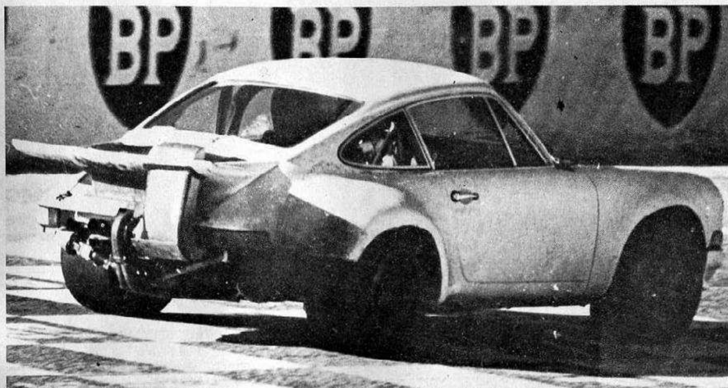
Questa è la Carrera «turbo» gruppo 4, cioè prefigurazione della GT «Silhouette» per il 1975. Il turbocompressore è montato dietro al motore, sulla destra.
